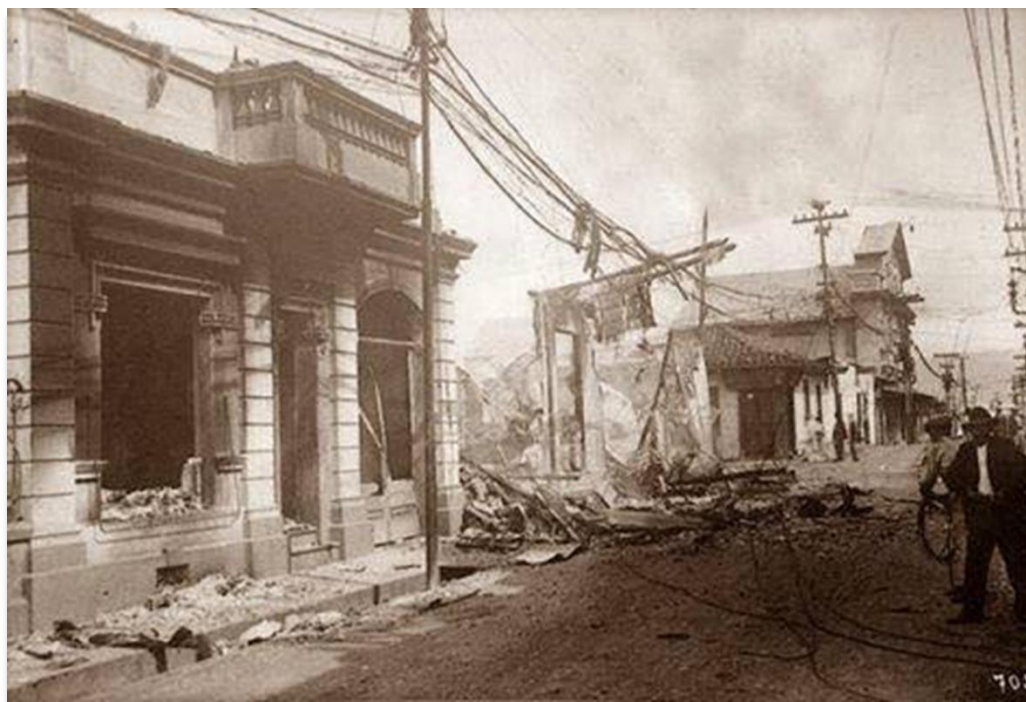
Figura 2. Edificio del diario La información , consumido por el fuego
